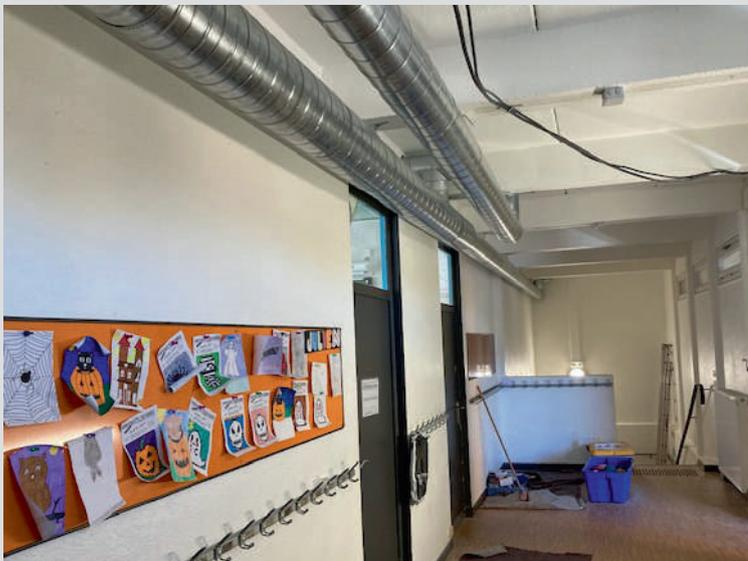
Les travaux se sont déroulés du 25 octobre au 10 novembre, l'entreprise MENIS Plâtrerie Peinture étant chargée de réaliser les cloisonnements et les plafonds nécessaires à l'intégration de la centrale de traitement d'air et du réseau de tuyauteries, pendant que Paul TEYSSEIRE s'occupait des travaux d'électricité.
