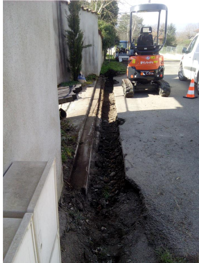
Installation d'une canalisation « route du Maréchal Ferrant »
