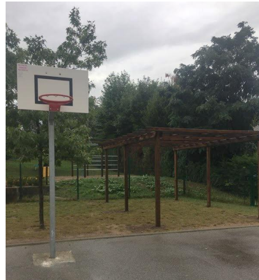
Installation de pergolas à l'école
