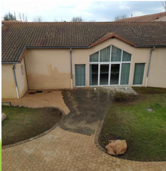
Nettoyage des dalles
