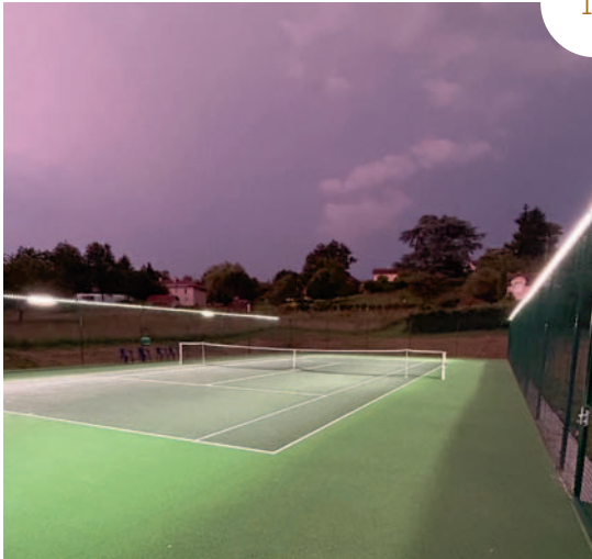
Mise en éclairage du nouveau terrain tennis (12).
