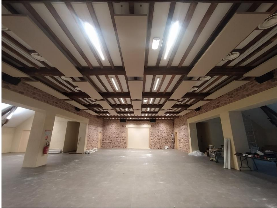
Changement des éclairages de la Grange de la Chamary
