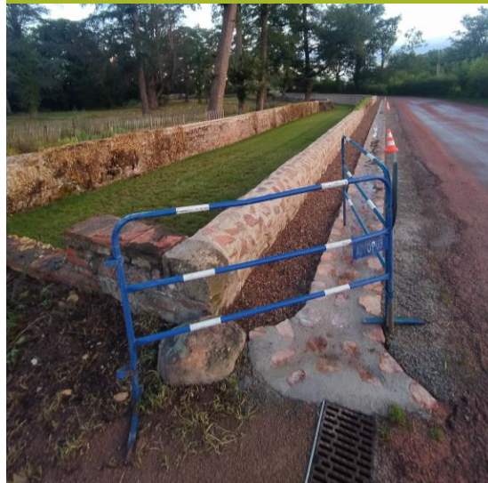
Reprise des accotements le long des douves
