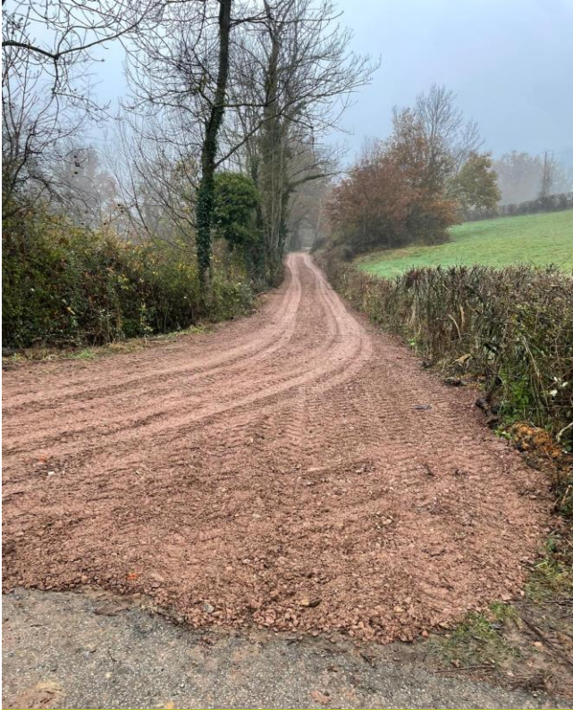
Reprise de la Traverse de la Goutte
