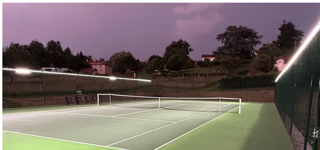
Installation de l'éclairage du terrain de tennis
