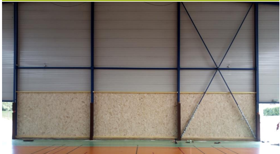
Bardage intérieur de la salle de sports
