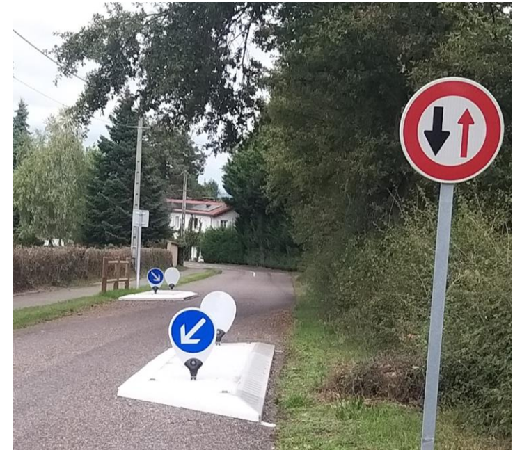
Ilots « route du Grand Cellier »
