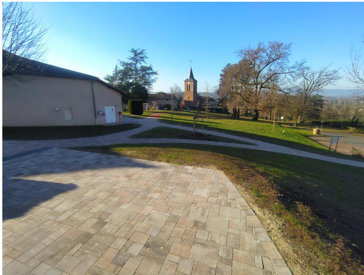
Phase 2 du pavage des abords de la Mairie – Salle des fêtes
