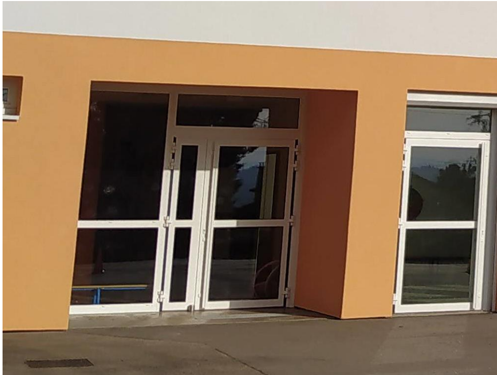
Porte d'entrée sud-ouest
